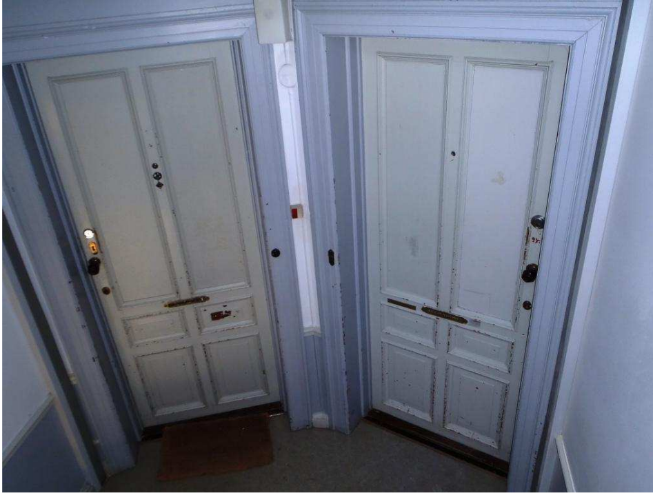
Hovedtrappe slidt træværk, revner/afskalninger på vægmaling
