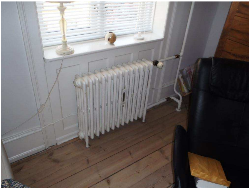
1-strengt anlæg med søjleradiatorer
