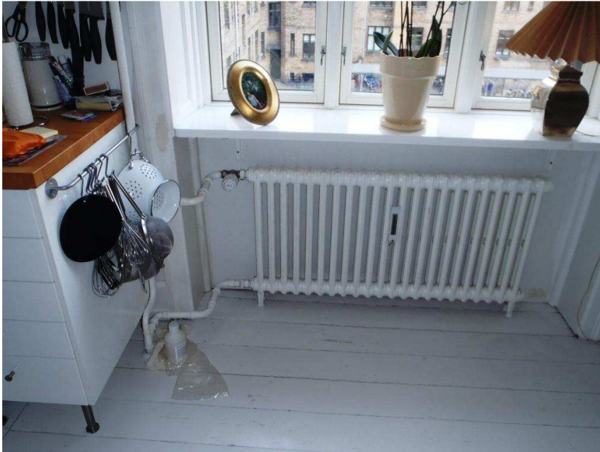
1-strengt anlæg med søjleradiatorer
